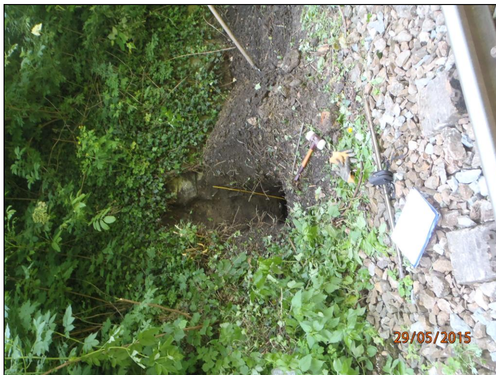
Obr. č. 3 - Kopaná sonda KS2 pro ověření hloubky založení opěrné zdi.
