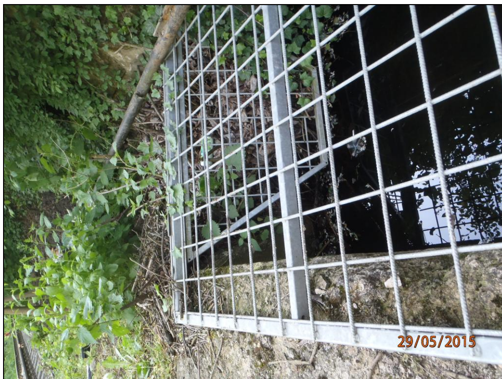
Obr. č. 4 - Pohled na vyústění příkopu v patě opěrné zdi do usazovací jámky. Příkop je nefunkční a zcela zanesený zemními materiály spadnými ze svahu nad opěrnou zdí.
